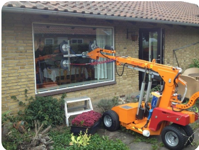
Plaatsen in een achtertuin zonder extra mankracht dus goedkoper werken
